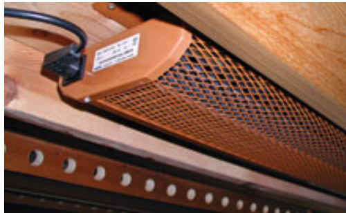
La puissance des appareils peut être réglée de diverses manières, en plusieurs paliers, avec un interrupteur ou un thermostat.
