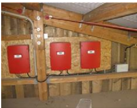
Il faut une autorisation spéciale pour installer des onduleurs sur une surface en matériau combustible
