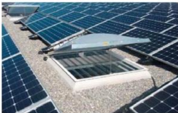
Puits de lumière avec grille de protection 35
