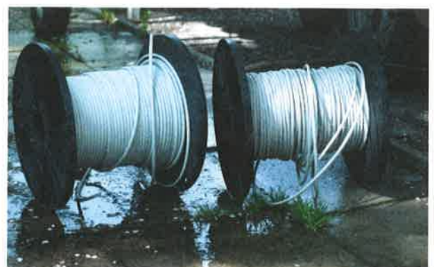
Figure 45: Incorrect: stockage des câbles en cuivre à l'extérieur
